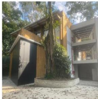
Edificio 18C Centro de Transformación de la Madera
