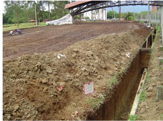
Fotos 1 y 2. Vista de las obras de adecuación; apertura de trincheras y movimiento de suelos por maquinaria pesada.
