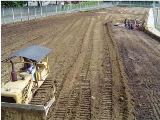
Fotos 1 y 2. Vista de las obras de adecuación; apertura de trincheras y movimiento de suelos por maquinaria pesada.
