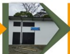
Centro de Almacenamiento Temporal
