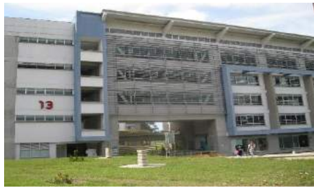
Bloque 13. Bodega para el almacenamiento de RAES
