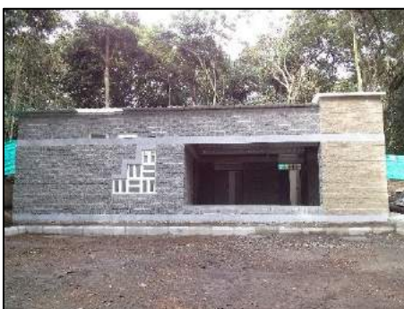
Almacenamiento central de RESPEL con riesgo químico
