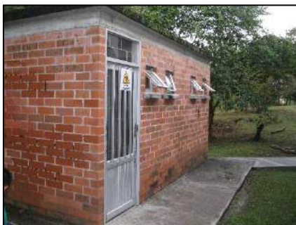
Almacenamiento central de RESPEL con riesgo biológico, Campus Universitario UTP
