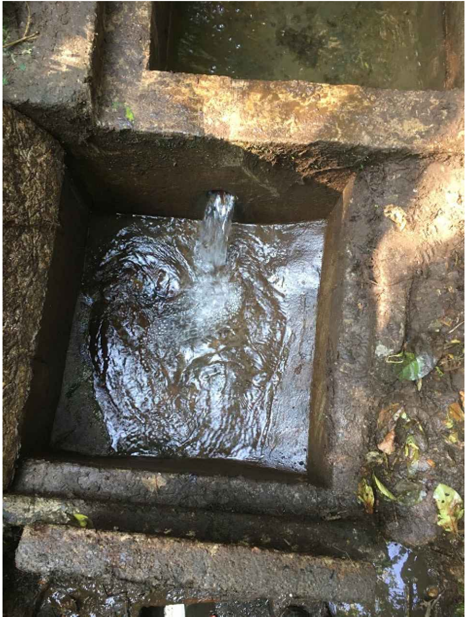
FOTOGRAFIA N° 6 CAJA DE PAJO BOCATOMA N° 1
