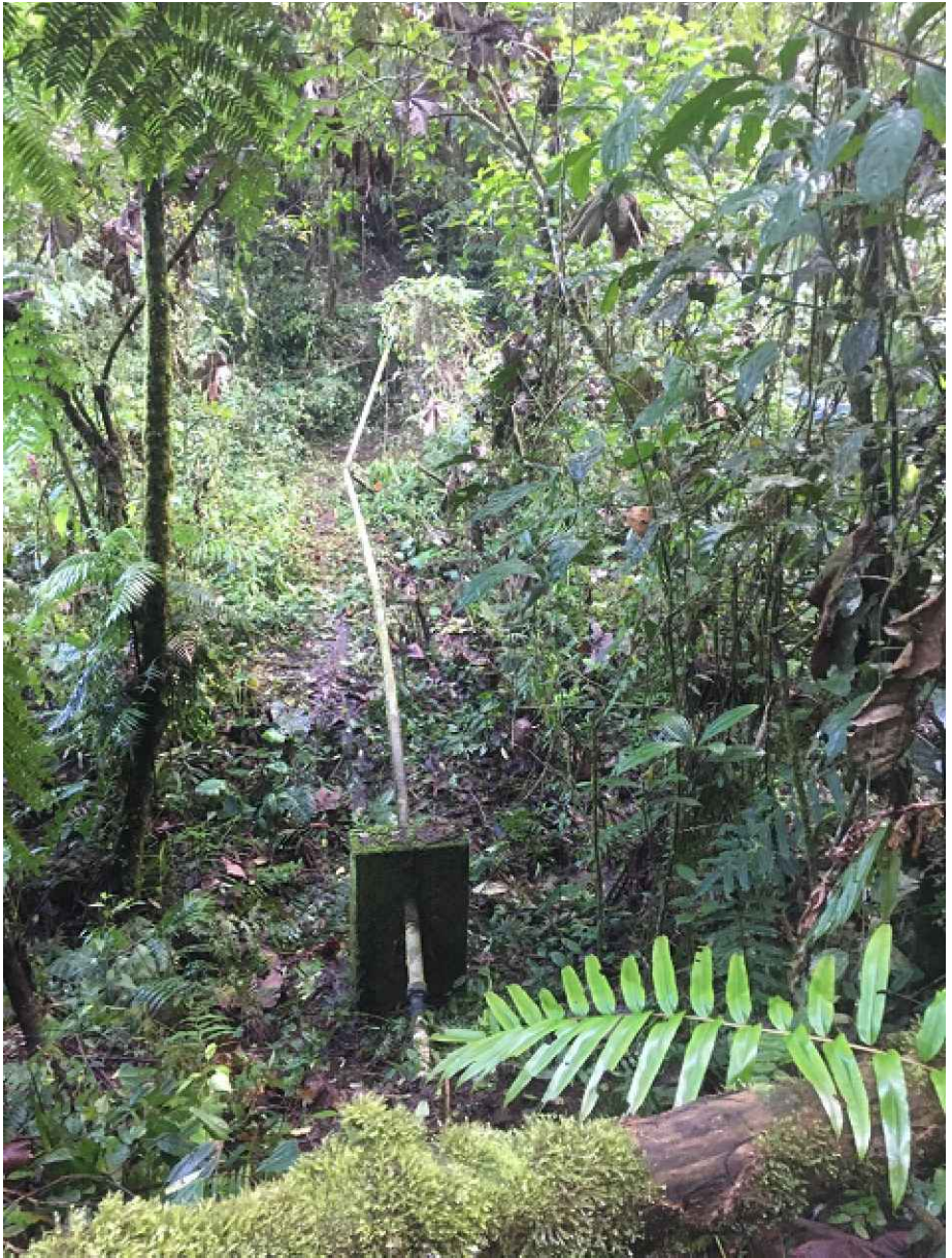
FOTOGRAFIA N° 7 LÍNEA DE ADUCCIÓN (VIADUCTO) BOCATOMA N° 1
