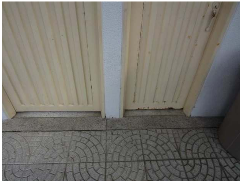
Detalle de piso a demoler y puertas a desmontar por reconfiguración de baños
