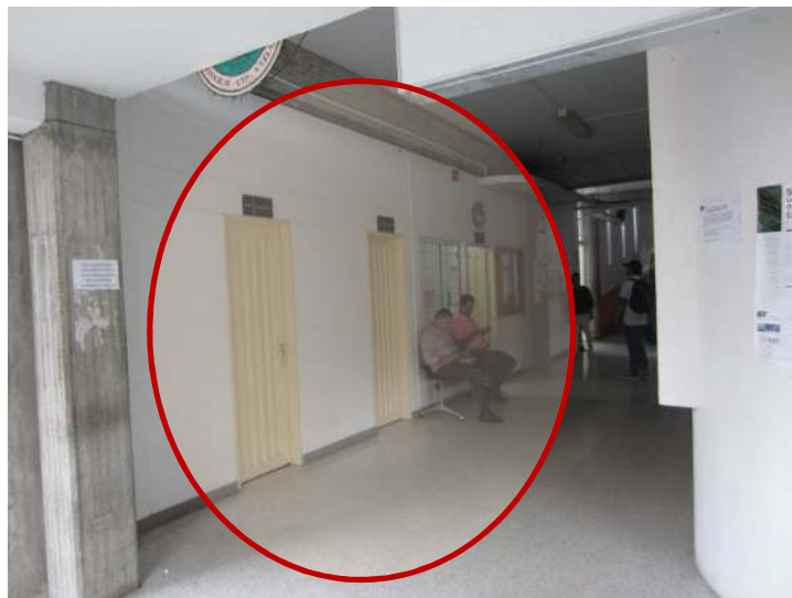
Detalle de puertas y ventanas a desmontar en ciencias Básicas, fachada lateral.
