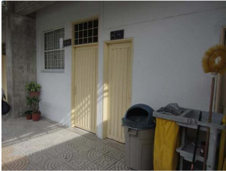
Zona de fachada, cuarto de aseo Ciencias Básicas
