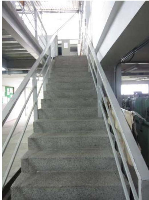
Detalle de pasamanos a desmontar en Mezanine de Mecánica (corresponde únicamente al pasamanos ubicado en el segundo piso)
