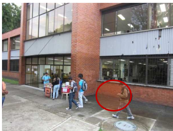
Detalle de muro de fachada a demoler en la Biblioteca Jorge Roa
