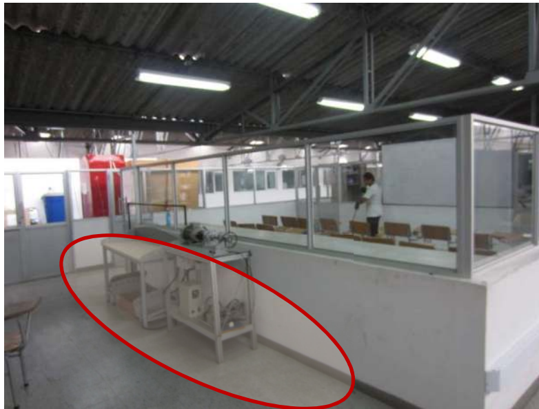
Detalle de uno de los sitios donde se puede presentar desmonte y reposición de piso en vinisol En laboratorio de Mecánica
