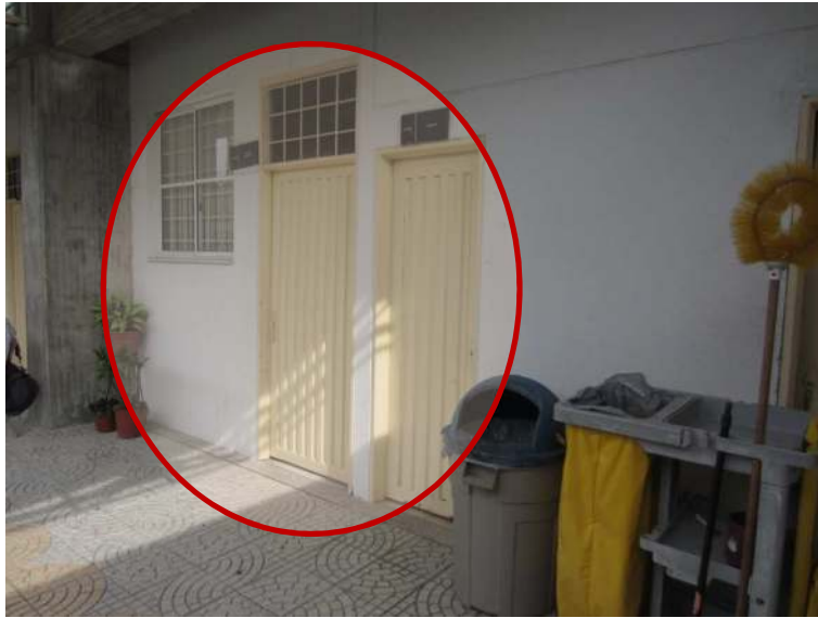
Detalle de puertas y ventanas a desmontar en ciencias Básicas, fachada Norte.
