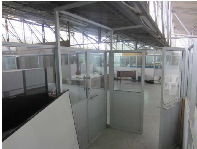
Detalle divisiones a desmontar en laboratorios de mecánica
