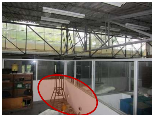
Ejemplo: muro laboratorios de mecánica
