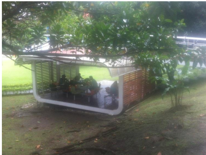
Módulo de estudio existente detrás del edificio de Eléctrica
