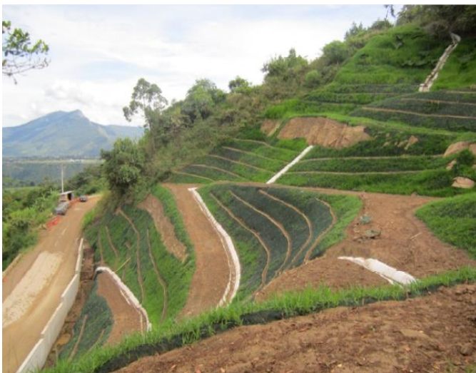
Foto 14. Foto ilustrativa del acabado con manto permanente para el control de erosión
