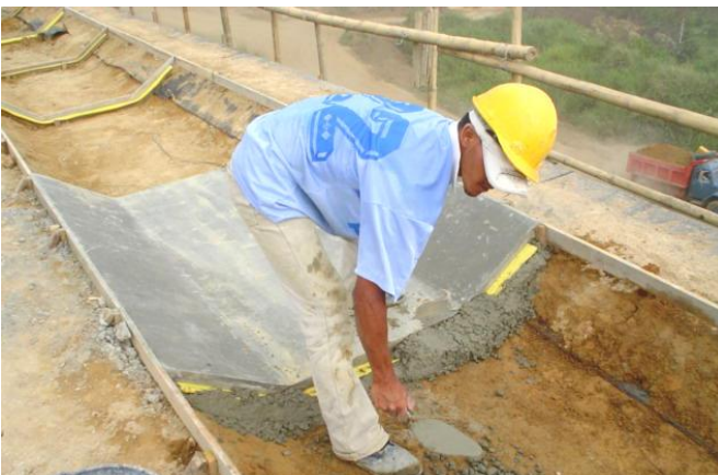
Foto 13. Detalle de construcción cuneta trapezoidal superior con dilataciones en cinta de PVC
