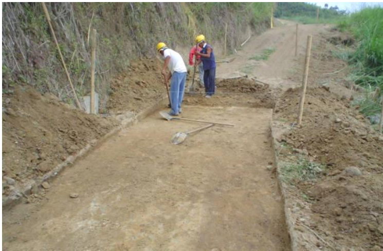
Foto 2. Labores de excavación manual para nivelación del terreno
