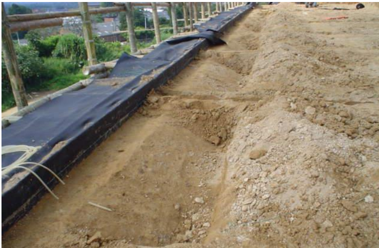
Foto 9. Excavación para colocación de doblez de geotextil
