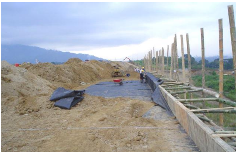
Foto 4. Colocación de geotextil. Nótese la formaleta
