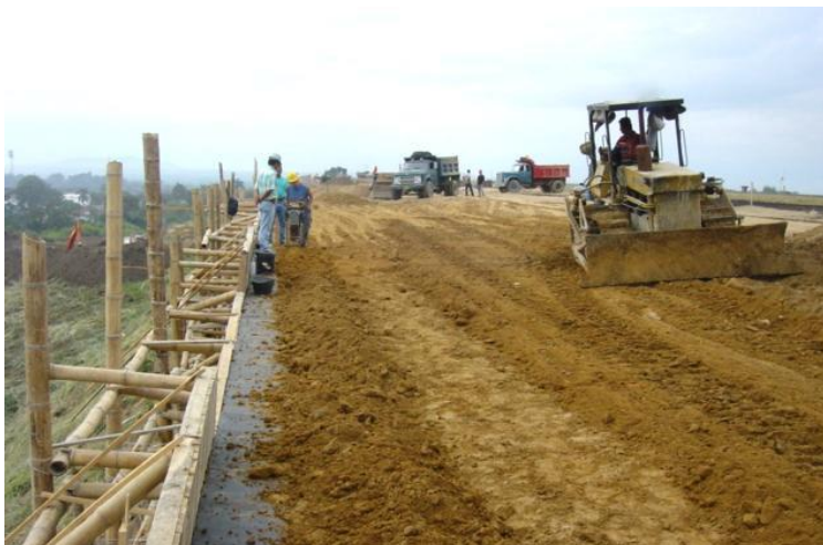
Foto 12. Compactación del lleno del muro con equipo liviano y pesado
