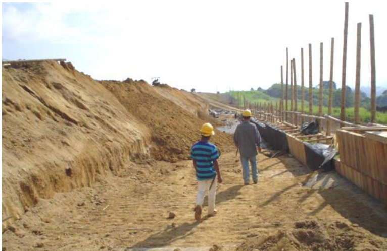
Foto 5. Colocación de suelo inorgánico para llenado del muro reforzado con geotextil
