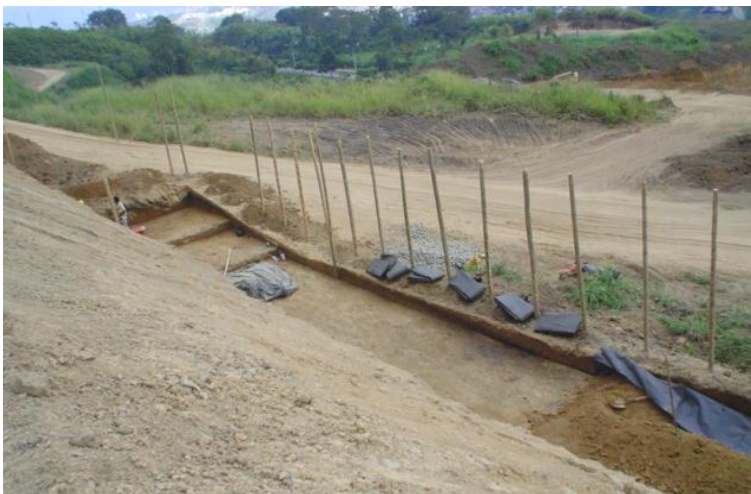
Foto 3. Organización de geotextil antes de su colocación
