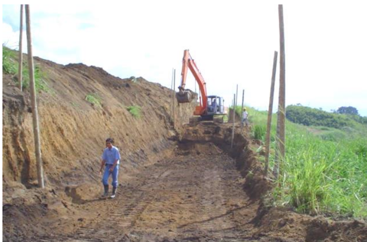
Foto 1. Labores primarias de excavación con maquinaria
