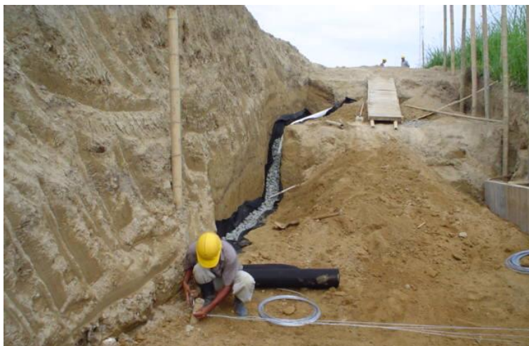
Foto 10. Detalle de filtro posterior en la pata del muro
