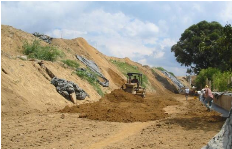
Foto 6. Riego y compactación del lleno con equipo pesado
