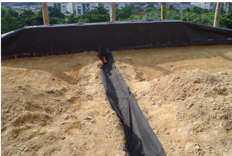
Foto 7. Detalle de construcción de filtros con geotextil
