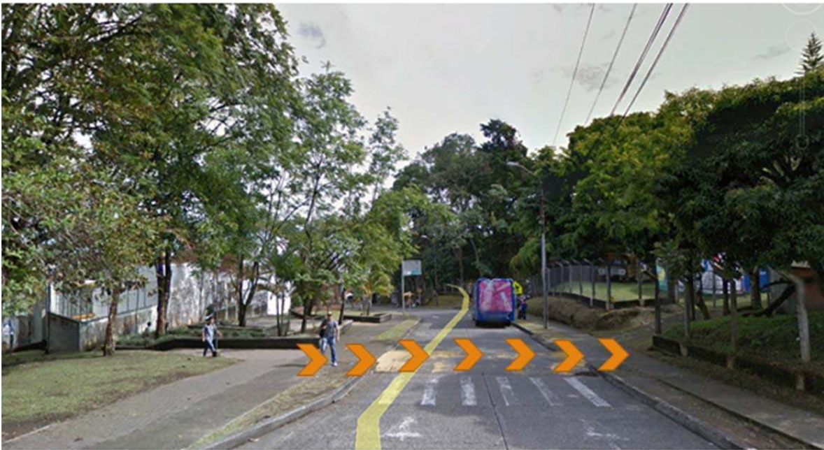
Fotografía 1. Localización del área donde se hará el túnel.
