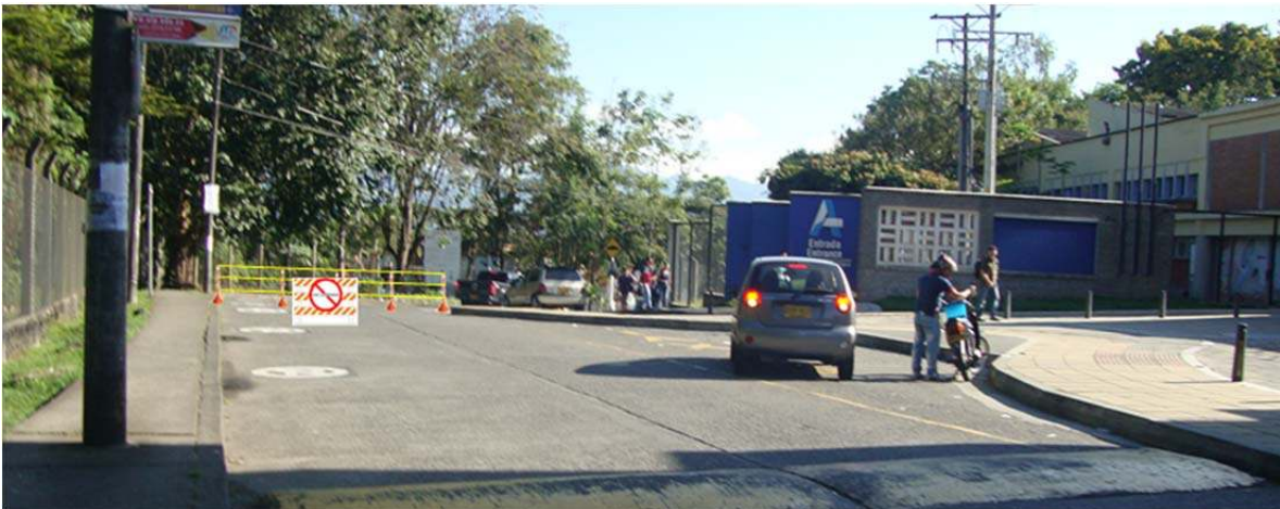
Fotografía 4. Cierre de la vía después del acceso principal de la UTP
